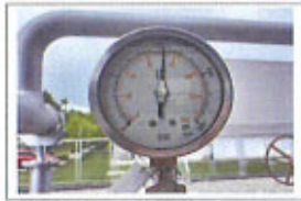
ความดันก๊าซก่อนเข้าอุปกรณ์รับลดแรงดัน
